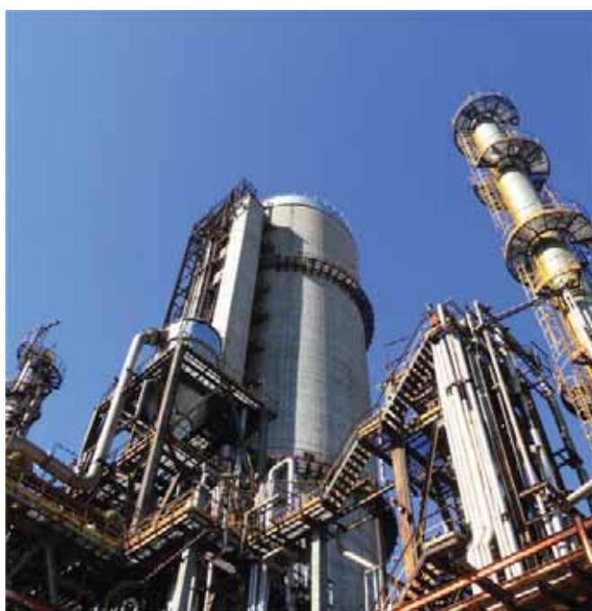
Instalimet dhe konstruksionet
