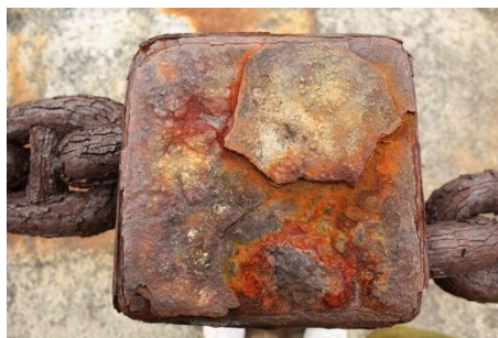
Figura 5.7. Korrozioni i një objekti prej hekuri
