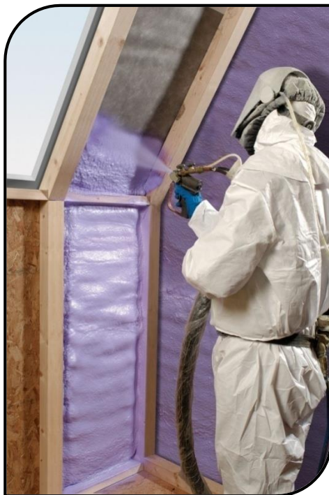
Сл.2.56. Нанесување на полиуретанска пена со прскање
