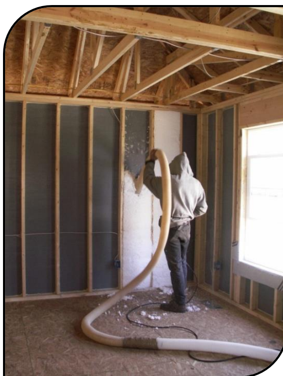
Сл.2.63. Изолирање со целулозни влакна со дување
