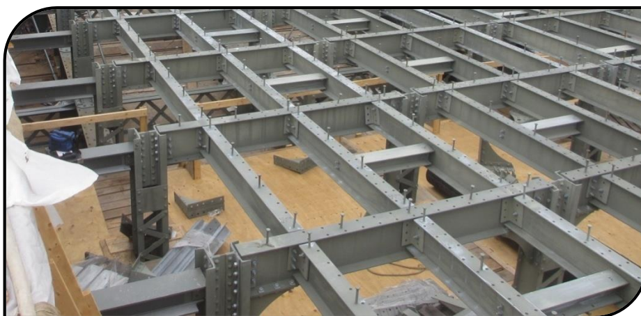
Сл.2.27. Носечка конструкција од челични метални профили
