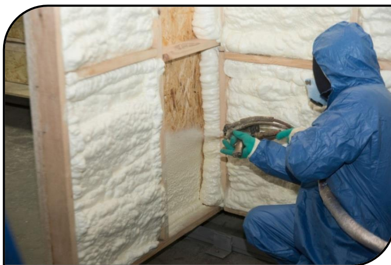
Сл.2.40. Изолирање со полиуретанска пена
