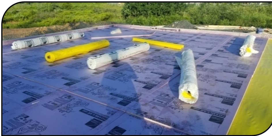
Сл.2.37. Хидроизолација на објект
