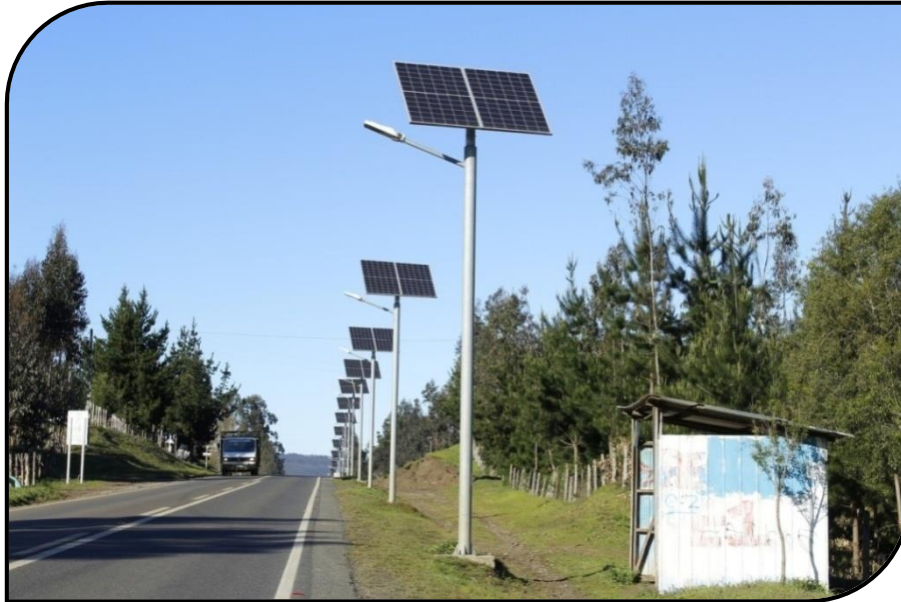
Сл.4.10. Улично осветлување со соларни светилки
