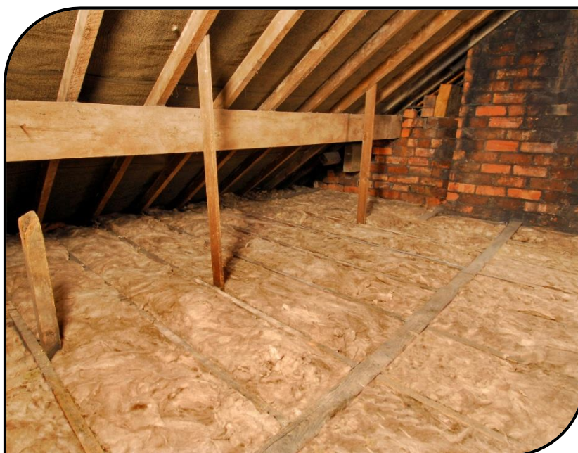
Сл.2.12. Изолација на највисокиот таван со стаклена волна
