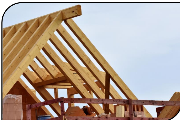
Сл.2.35. Основа на кровна конструкција од дрво
