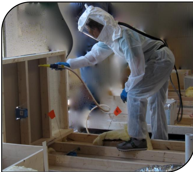
Сл.2.43. Нанесување на течна изолација со прскање
