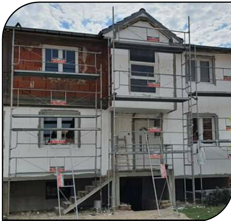
Сл.3.70. Изолација на фасада на нов објект
