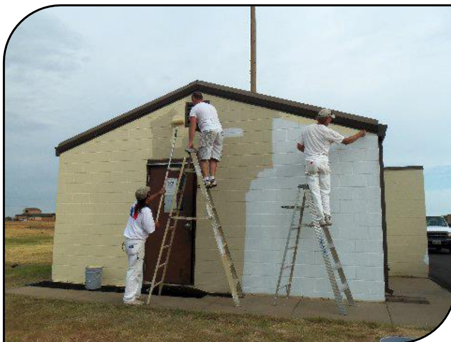
Сл.2.67. Изолирање на надворешен ѕид со течна изолација
