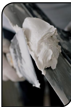
Сл.2.22. Подготвен гипс за работа
