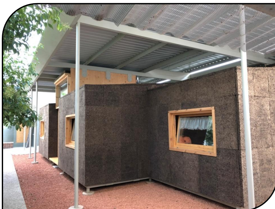
Сл.2.59. Изолирање и естетско уредување на објект со плочи од плута
