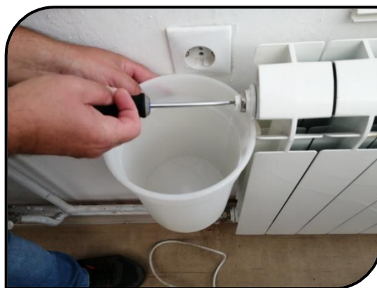
Сл.3.75. Обезвоздушување на радијатор
