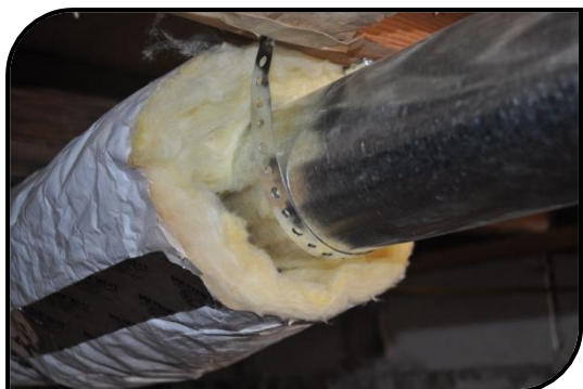
Сл.3.71. Изолација на цевки со стаклена волна и фолија
