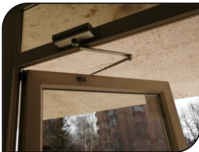
Сл.3.73. Механизам за затворање на надворешна врата
