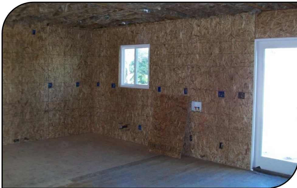
Сл.2.61. Изолирање на внатрешната страна на ѕидот со панели од дрвени влакна
