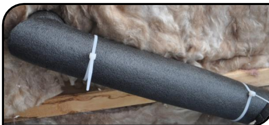
Сл.3.72. Изолација на цевки со армафлекс
