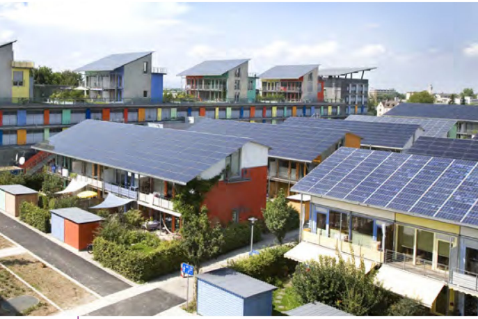
Daha temiz hava için güneş enerjisinin daha fazla kullanılması. Fotovoltaik.
