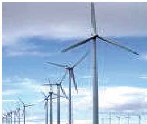
Figura 5.2 Përdorimi i energjisë së erës
