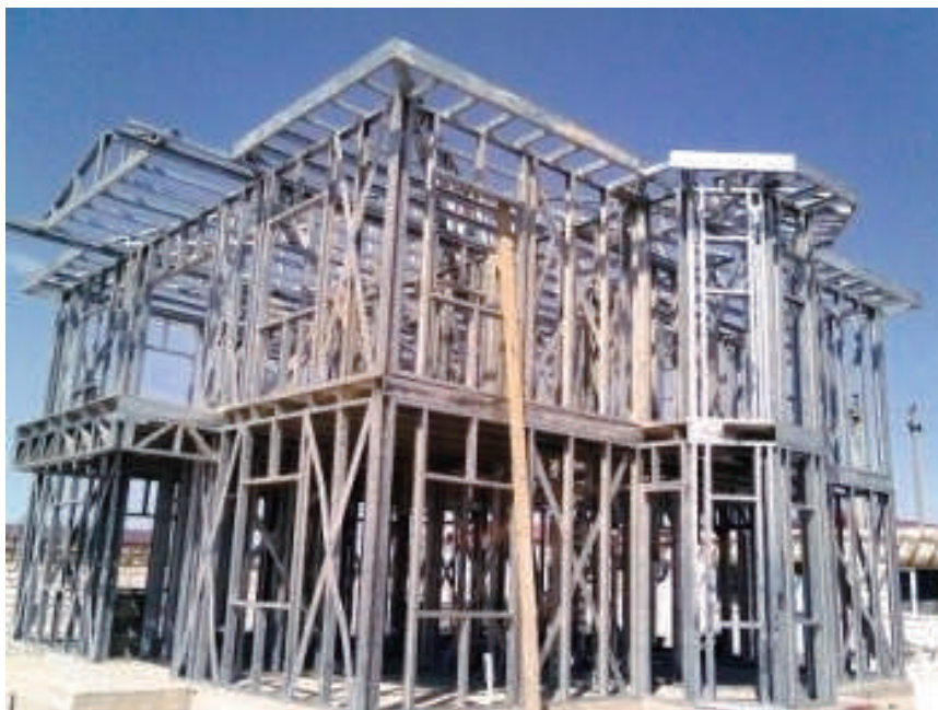
Figura 7.2 Konstruksioni i çelikut
