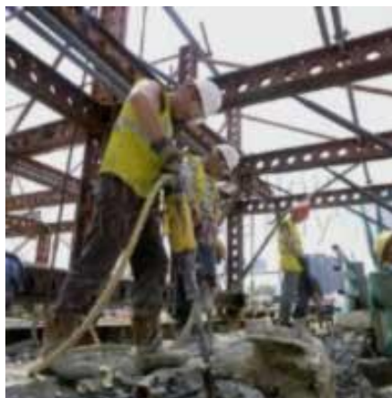
Сл.63. Работа со пневматски дупчачки чекан
