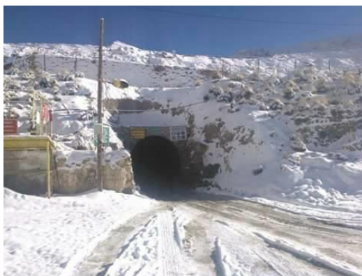
Сл.7. Рудник со подземна експлоатација.
