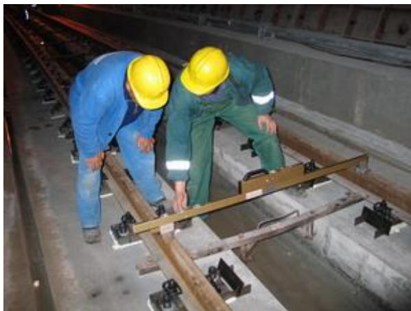
Сл.1. Работно место – поставување на колосек за железнички транспорт.
