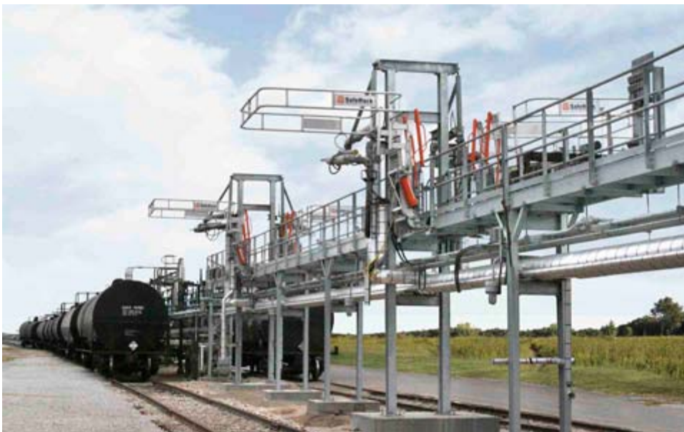
Слика 7.19. Товарње на цистерни со течен вид стока (нафтени деривати)
