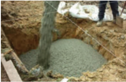
Temellere beton dökme
