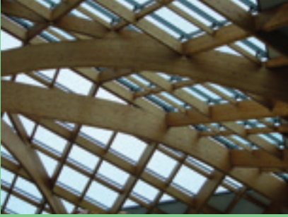
Lamelli odundan (ahşap) çatı konstrüksiyonu
