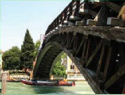
Odun (ahşap) köprü konstrüksiyonu
