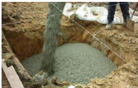
Бетонирање темеља
