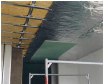
Изолација таванске површине
