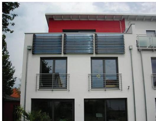
*Сончевите колектори се многу економични, заштедуваат енергија при догревање и создавање топла вода за кайење*
