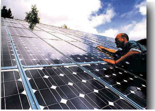
Şekil 5. Fotovoltaik panosunun çatıda monte edilmesi
