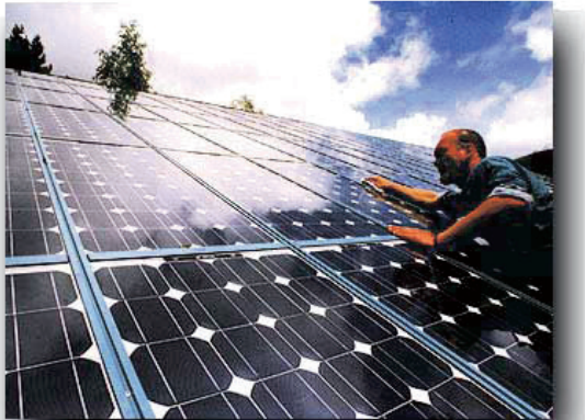
Fig. 5. Montimi i panelëve fotovoltaik në çati
