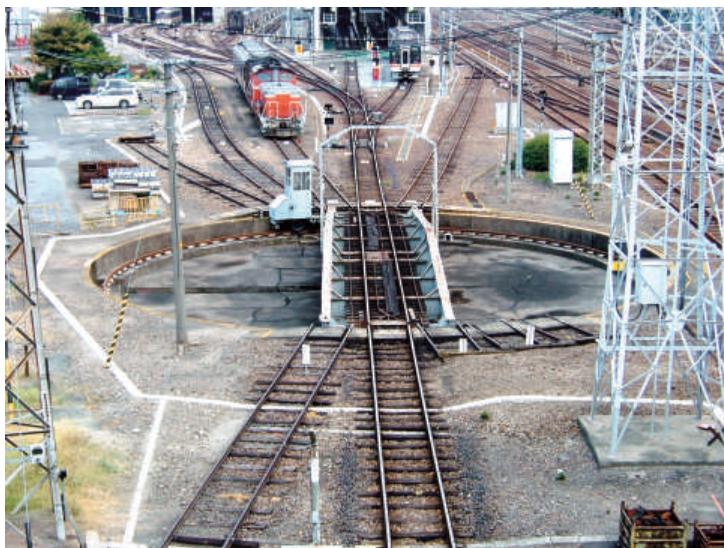
Fig. 5.1. Ndërruesit e kahjes lokomotive
